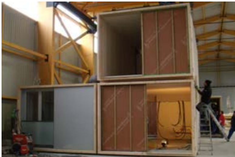
50 logements modulaires bois
