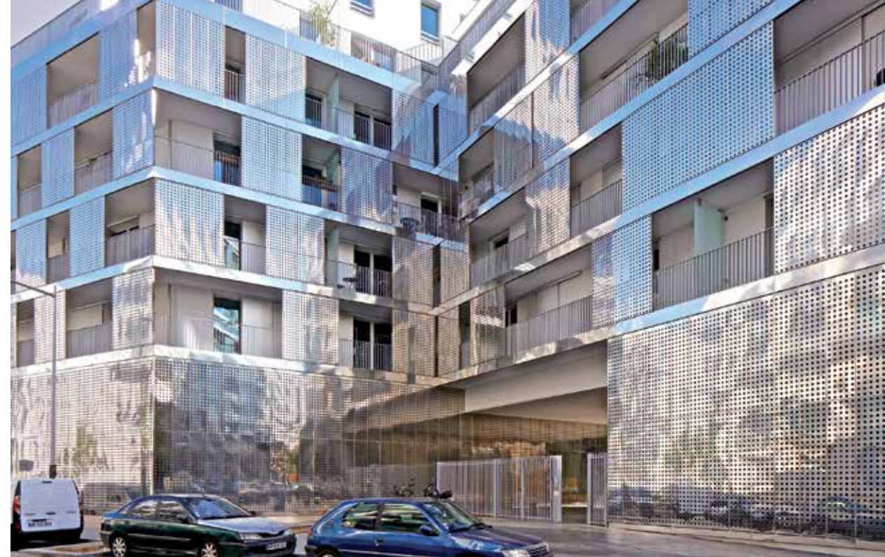
Les panneaux perforés rue de Meudon. Ph © Philippe Ruault.
